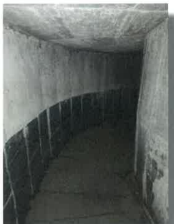
Cunicolo scatolare in calcestruzzo faccia vista (non intonacato), con fondo e spalle rivestiti in lastricato in pietra fuggata
