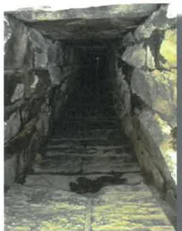
Cunicolo scatolare in pietra
