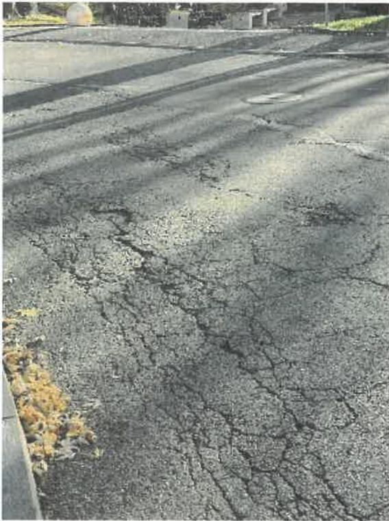
Foto 1: Asfalto alla curva di fronte alle SE.
