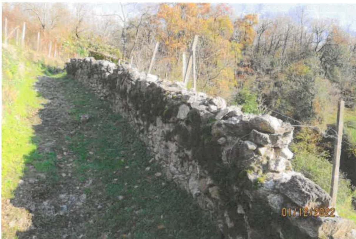
Foto 5 – Gli ultimi 15 metri di muro sono meno problematici.
