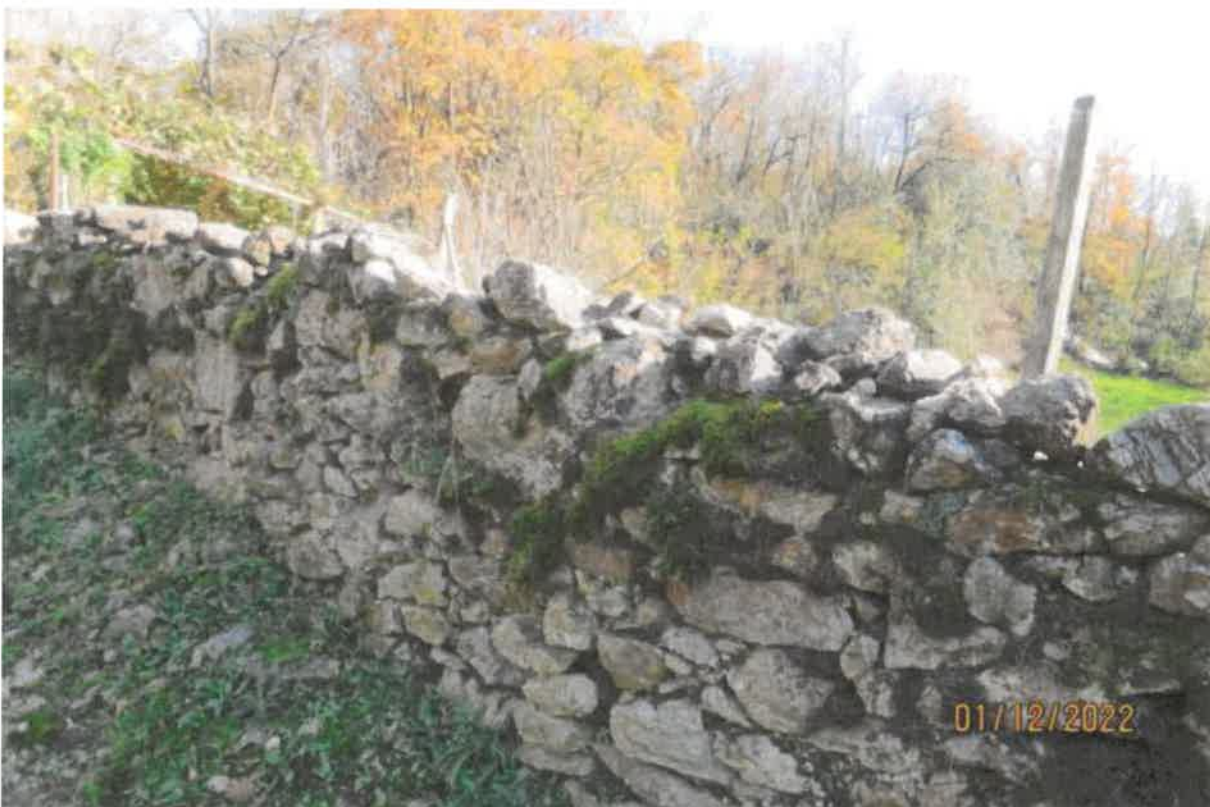
Foto 6 – È sufficiente smontare e fissare bene con malta di cemento le pietre già presenti.
