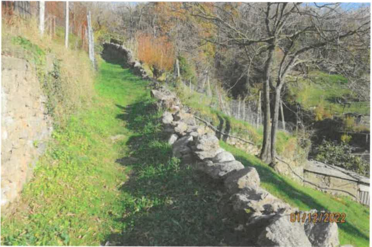
Foto 3 – Con i sassi più grandi si può fare una copertina molto resistente.
