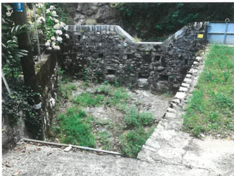
Veduta generale della porzione di valle della vasca di trattenuta
